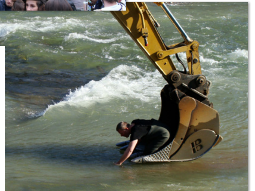
Wartungsarbeiten bei einer Geschiebemessanlage. Foto: Strahlhofer/Hugo Seitz
